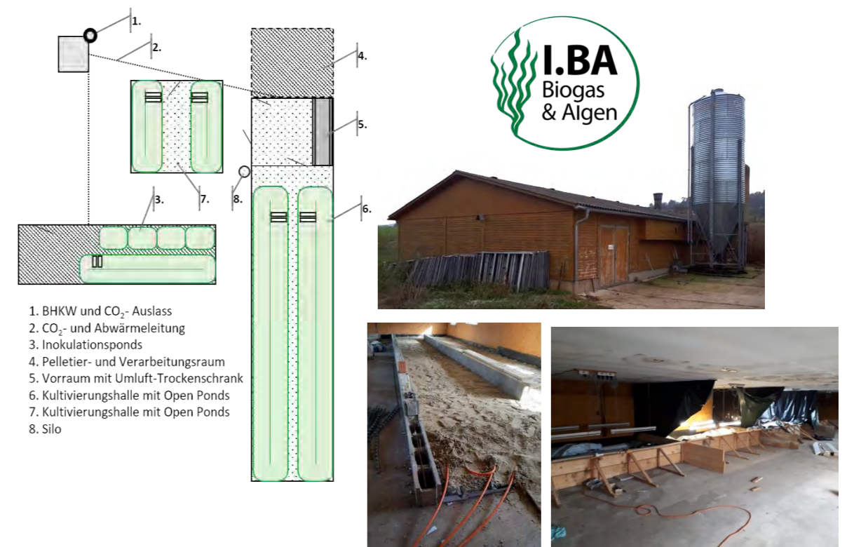
Abb. 2: Umbau eines entkernten Hühnerstalls zu einer kommerziellen Algenkultivierungsanlage mit 20 m 3 -Ponds
